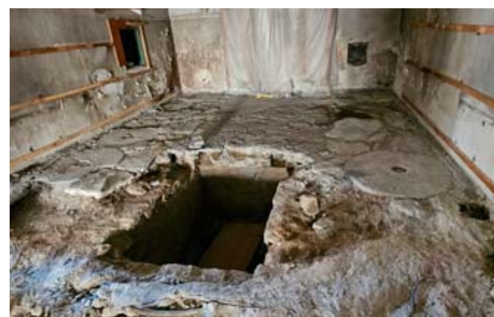
Lors des travaux de démolition, les ouvriers ont découvert un tombeau caché sous le chœur et des anciennes meules à grains réutilisées lors de la construction de l'église. DR
